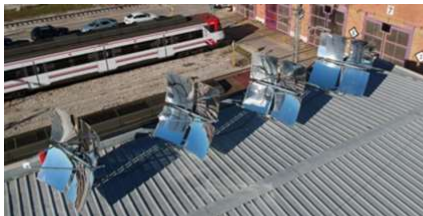
Figuur 12: Mogelijkheid tot plaatsing op daken. (Foto TCT, www.TrueSolarPower.com )
