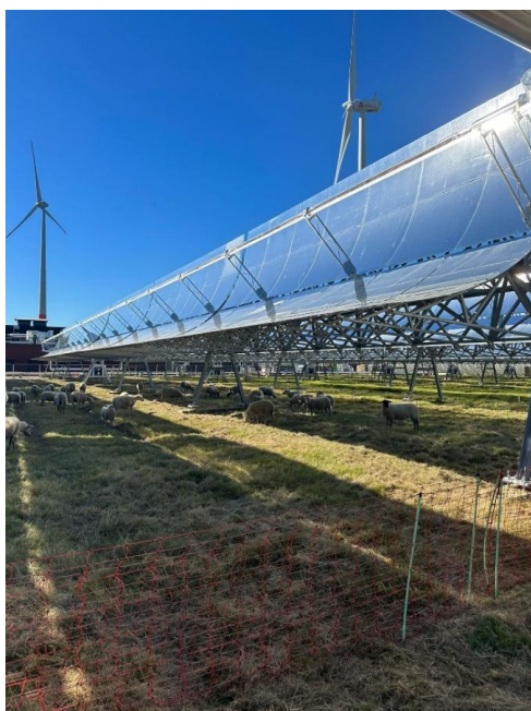
Figuur 6.24 | Trogspiegel-installatie van Aztec bij Avery Dennison in Turnhout, met dubbelgebruik als schapenweide.
