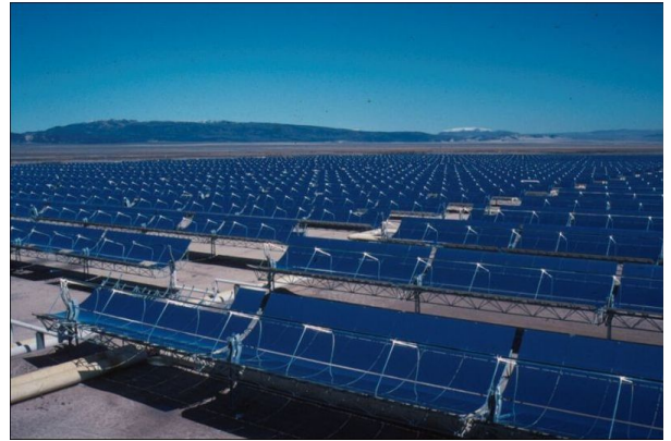
Parabolisch trog collector veld voor de zonthermische centrale te Kramer Junction, Californië
